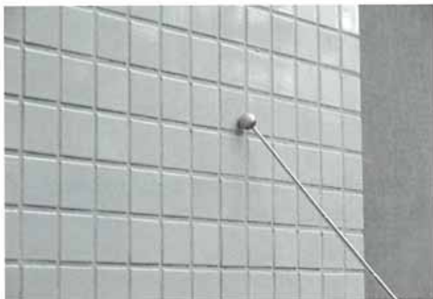
打検ハンマーによる打診検査
