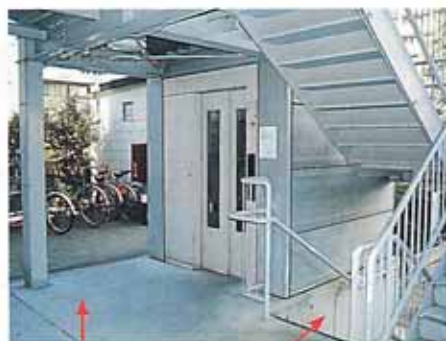
低層棟の1階踊り場はフラットに出来た スロープが無いと半階段は階段が残る
