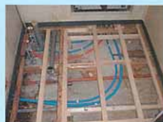
室内は工事しやすいサヤ管ヘッダー方式へ（参考写真）
