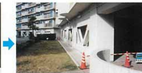
改修後（ブレースでしっかり補強）
