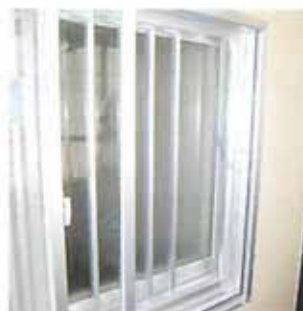
サッシの間に非常脱出面格子を取り付けて廊下側に出っ張るのを避けた。
