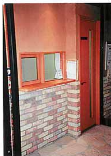
改修後 管理室窓口
