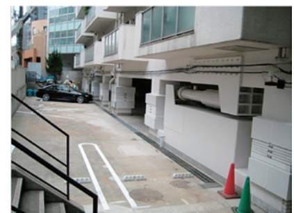
〈工事箇所：免震装置〉
