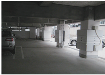
〈工事箇所：免震装置〉
