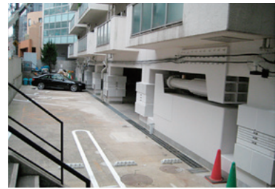
〈工事箇所：免震装置〉
