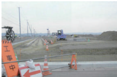
〈造成中の玉浦西団地（平成26年3月撮影）〉
