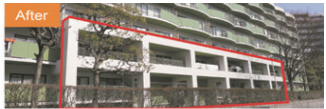
耐震改修工事後：一部住戸のバルコニーの外側にフレームを設置
