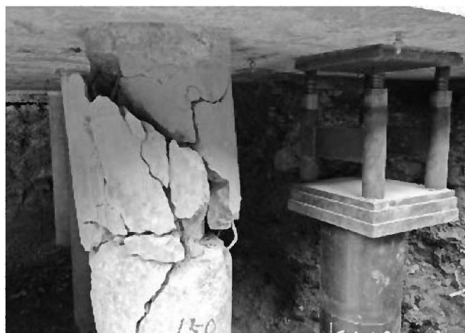
【写真-2】 熊本地震で杭が損傷した公営集合住宅の復旧工事
