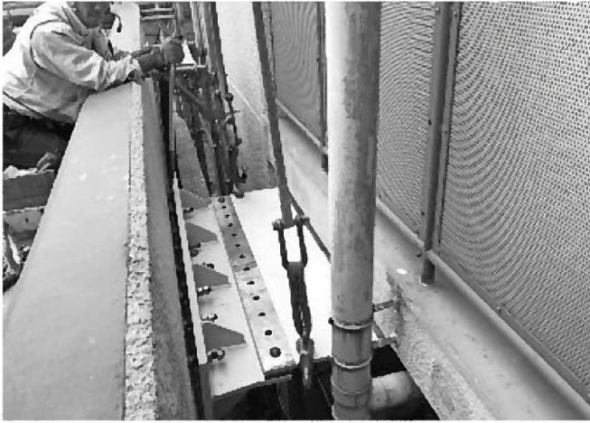
【写真-3】 耐震補強にかかる工事は補助金の対象
