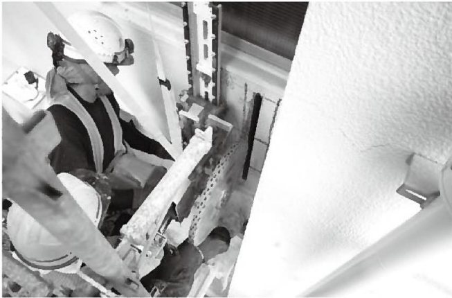
耐震スリットの施工状況
