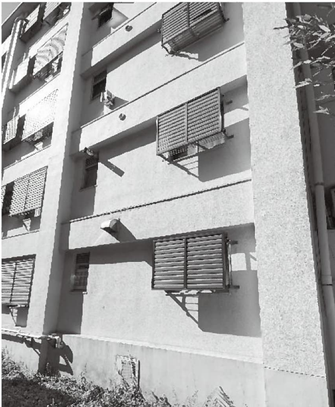
改修前（壁増し打ち補強箇所）
