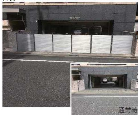
③ 電気設備室等への浸水を防止する対策 (例：防水扉の設置)
