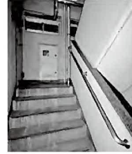
エレベーター未設置 ◆最上階から空家が増加。 ◆救急搬送に支障が生じる等の課題も。
