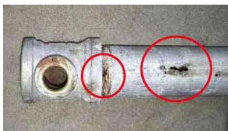
排水管外部の腐食（錆と漏水跡）
