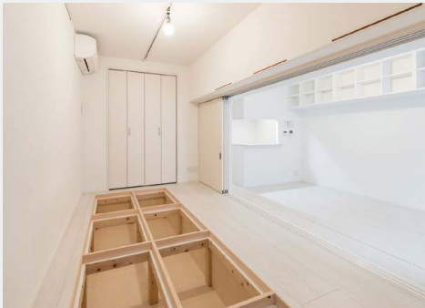
逆梁工法を利用した床下収納
