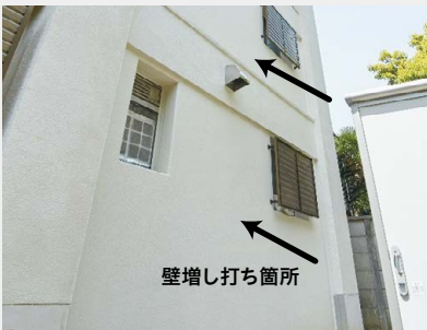
耐震増し打ち壁
