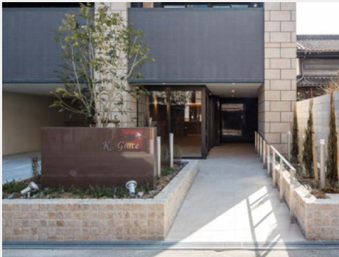
スロープ・手すり
