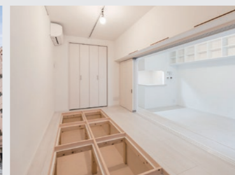
逆梁工法を利用した床下収納
