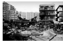
震災で被害を受けた住宅
