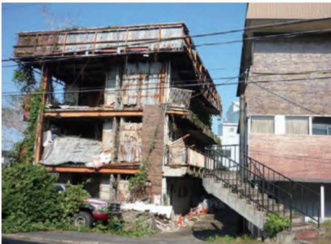
図6 行政代執行により除却されたマンション
