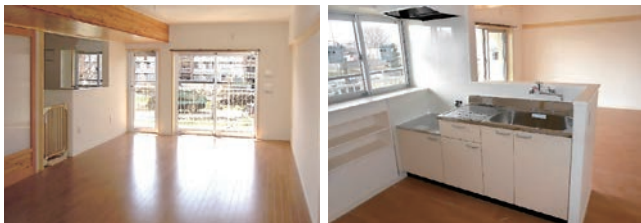
衝撃吸収性のあるフローリングへの改修
