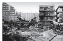
震災で被害を受けた住宅
