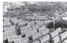
都市近郊に建設された大規模団地
