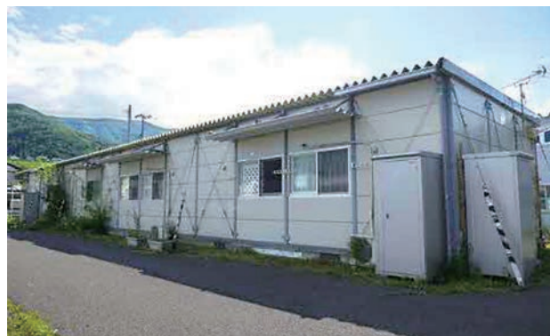
東北の仮設住宅 外観
