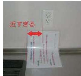
コンセントは、ガスコンロの両端部から15cm以上離す必要があります。(※消防法、火災条例等による) また、漏電事故を防止するため、水廻りにあまりにも近い場合は避ける又は、防水型コンセント等を利用するのが望ましいです。
