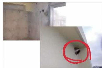
【図1】区分所有者の独断で外壁を壊し、エアコンスリーブを開通
