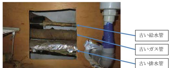
【図5】錆びた鉄製の水道管が交換されていない
