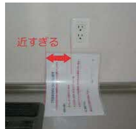
【図3】ガスコンロからコンセントまでの距離が近すぎる
