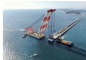
高知港ケーソン据付
