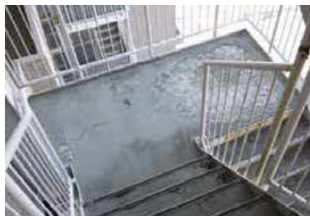
損傷した外階段の改修（防水改修、消音シートの張りつけ等）
