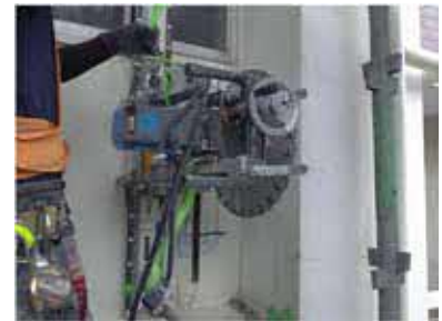
【構造スリットの施工】
