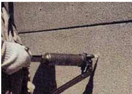
アンカーピンニング工法による修繕
