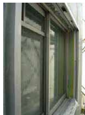
サッシの二重化 (外付け工法による)
