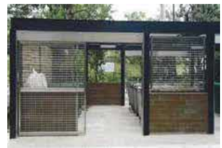
屋根付きゴミ置き場の整備
