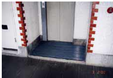
エレベーター出入口の段差の解消
