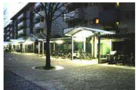
夜間照明増設による防犯機能強化
