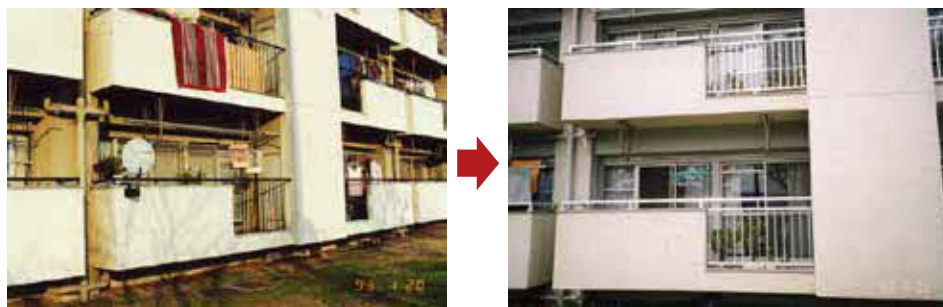
鉄部手すりのバリューアップ
