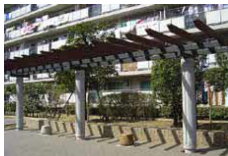
パーゴラ・ベンチの設置
