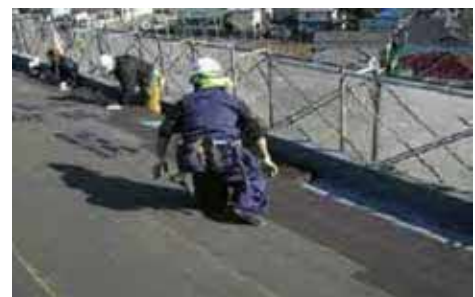
屋上防水改修工事の様子
