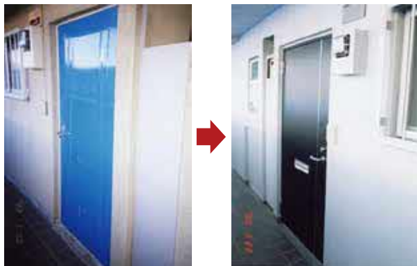
玄関ドアのバリューアップ (プレスドア⇒フラッシュドア)
