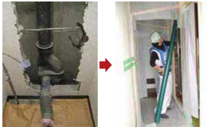
専用部内の排水立管の更新
