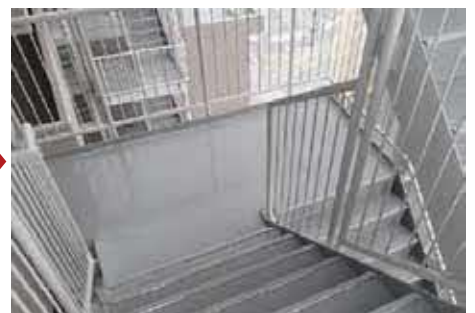
損傷した外階段の改修（防水改修、消音シートの張りつけ等）
