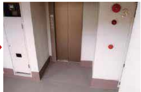
エレベーター出入口の段差の解消
