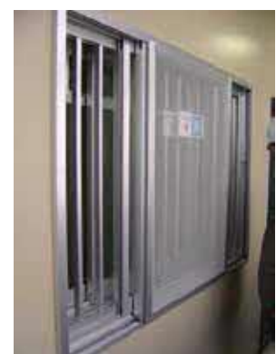
非常時脱出機能付き 面格子の設置
