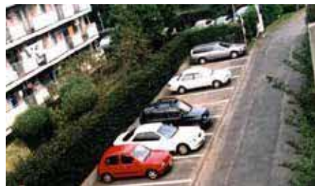
植生ブロック舗装による駐車場の緑化
