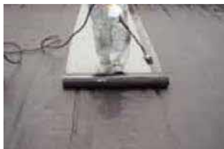
かぶせ工法による屋上防水改修
