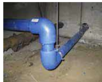
(床下ピット内)
