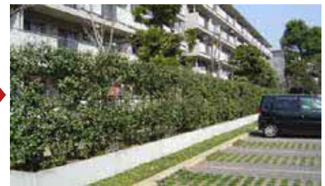
植生ブロック舗装による駐車場の緑化
