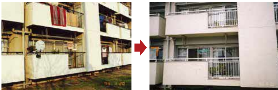
鉄部手すりのバリューアップ
