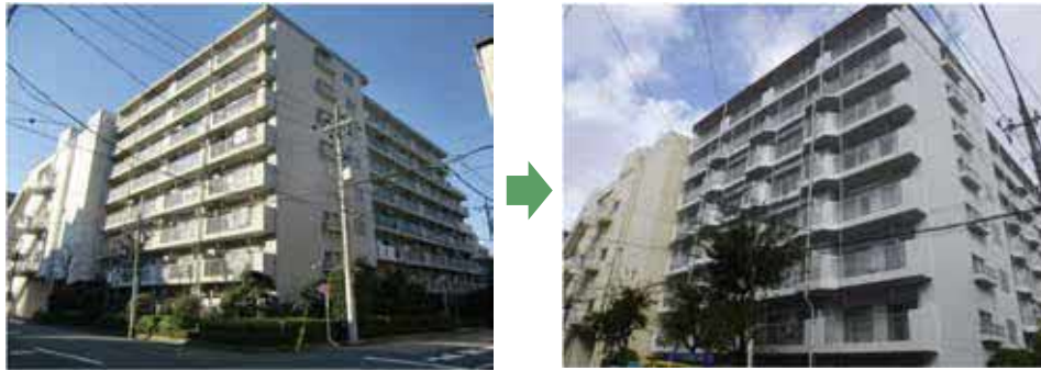
【外観（外壁塗装、耐震改修）】
