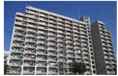
【耐震改修（制震ブレース工法）】
