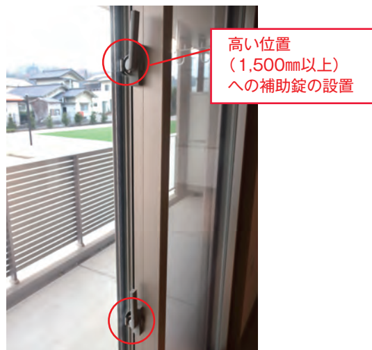
【写真1】窓サッシの2か所（1か所は小さな子どもの手の届かない高さ）に取り付けられたクレセント錠
