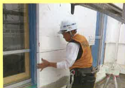
【外壁の外断熱改修】
