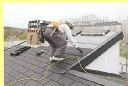
【屋根の改修工事】
